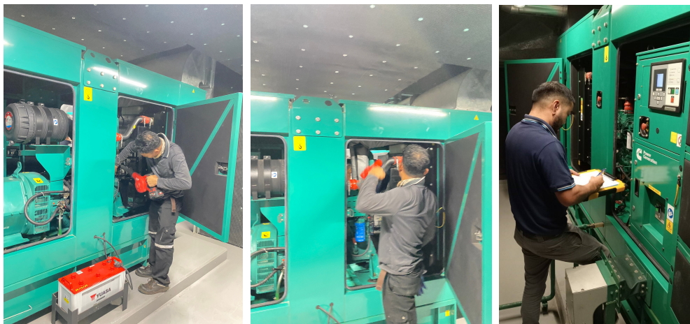
ภาพที่ 3-12 ห้องเครื่องไฟฟ้าฉุกเฉิน บุด้วยวัสดุกันเสียงและการทดสอบประจำสัปดาห์
