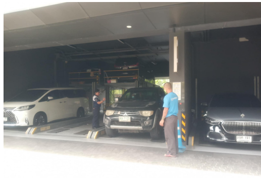
ภาพที่ 3-4 ที่จอดรถไฟฟ้าแบบเคลื่อนย้ายด้วยเครื่องจักร
