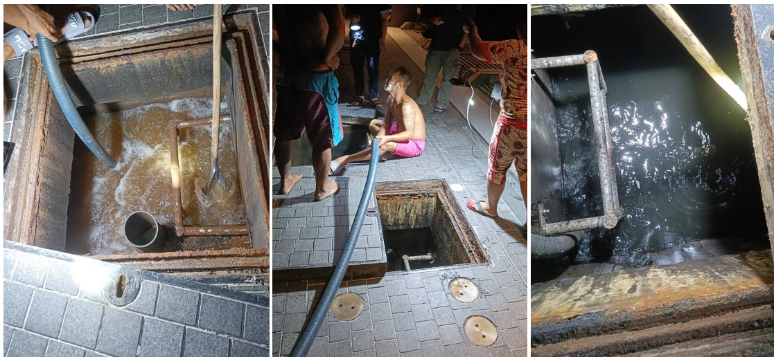
ภาพที่ 3-41 ดูแลรักษาระบบบำบัดน้ำเสีย ดูดตะกอนและดูแลรักษาระบบระบายน้ำ
