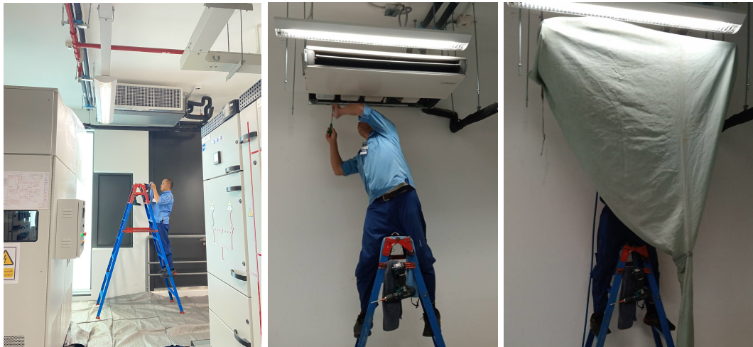
ภาพที่ 3-34 ล้างเครื่องปรับอากาศ ภายในอาคาร
