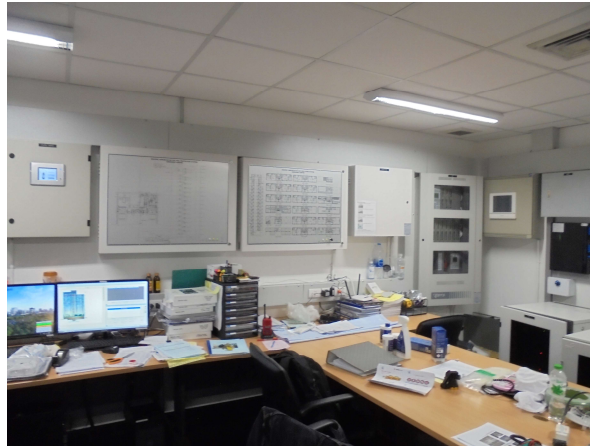
ภาพที่ 3-19 ห้องแผนกควบคุมการรับส่งสัญญาณอุปกรณ์ชุดแจ้งเหตุอัคคีภัย และหลอดประหยัดไฟ LED
